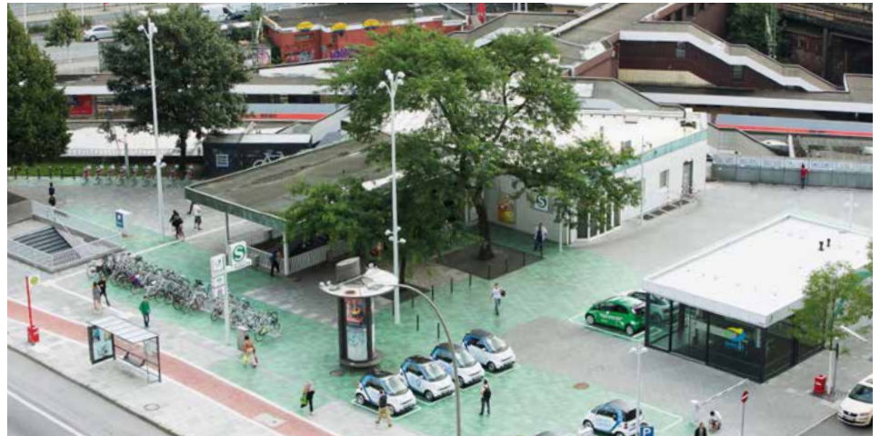
Exemple de centre intermodal de transport, Switchh Punkt Berliner Tor, Hambourg, Hochbahn Hamburg
