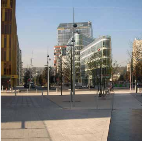
Exemple de bâtiment phare, Trapèze ouest, Cours Seguin et traverses, AAUPC, Patrick Chavannes, Boulogne Billancourt
