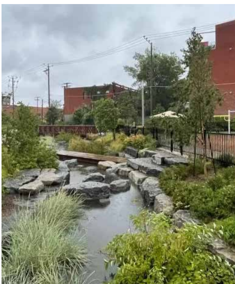
Exemple d'aménagement assurant la gestion des eaux de surface, Parc Pierre-Dansereau, Ville de Montréal
