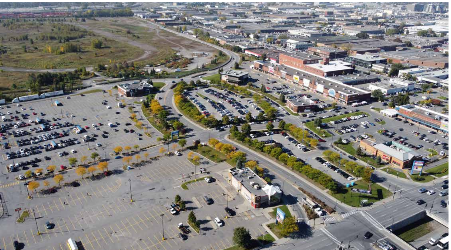
Aires de stationnement à ciel ouvert et terrain vacant de l'hippodrome qui pourraient accueillir de nouvelles fonctions urbaines
