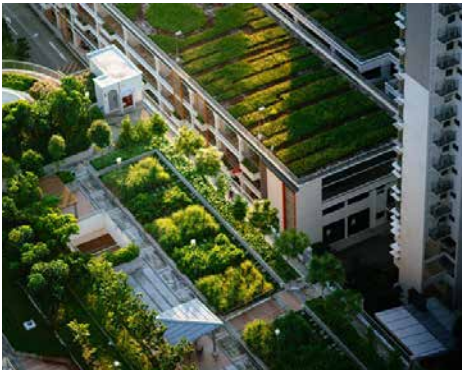
Toiture végétalisée, Groupe Leclerc, architecture+ design
